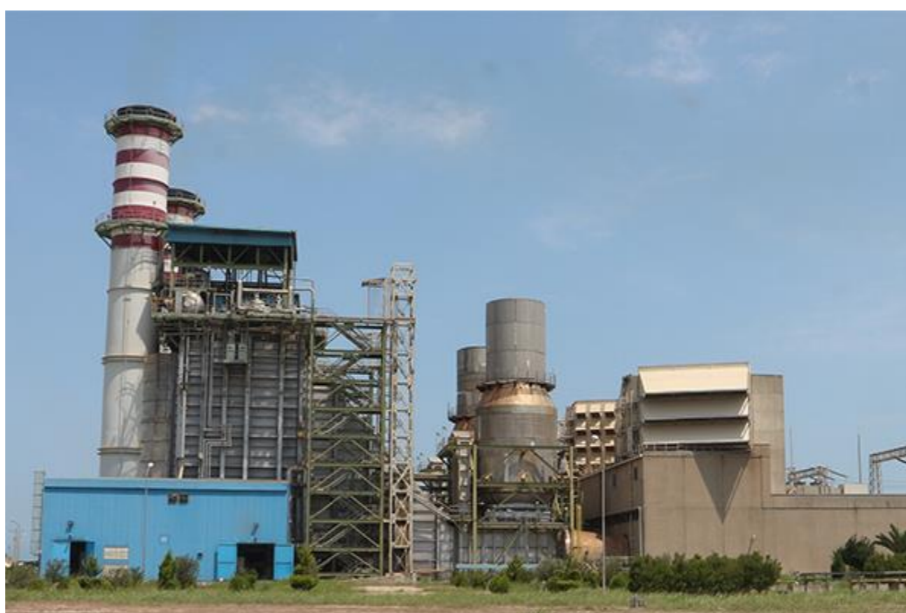
شکل ۲ واحد سیکل ترکیبی نیروگاه نکا
