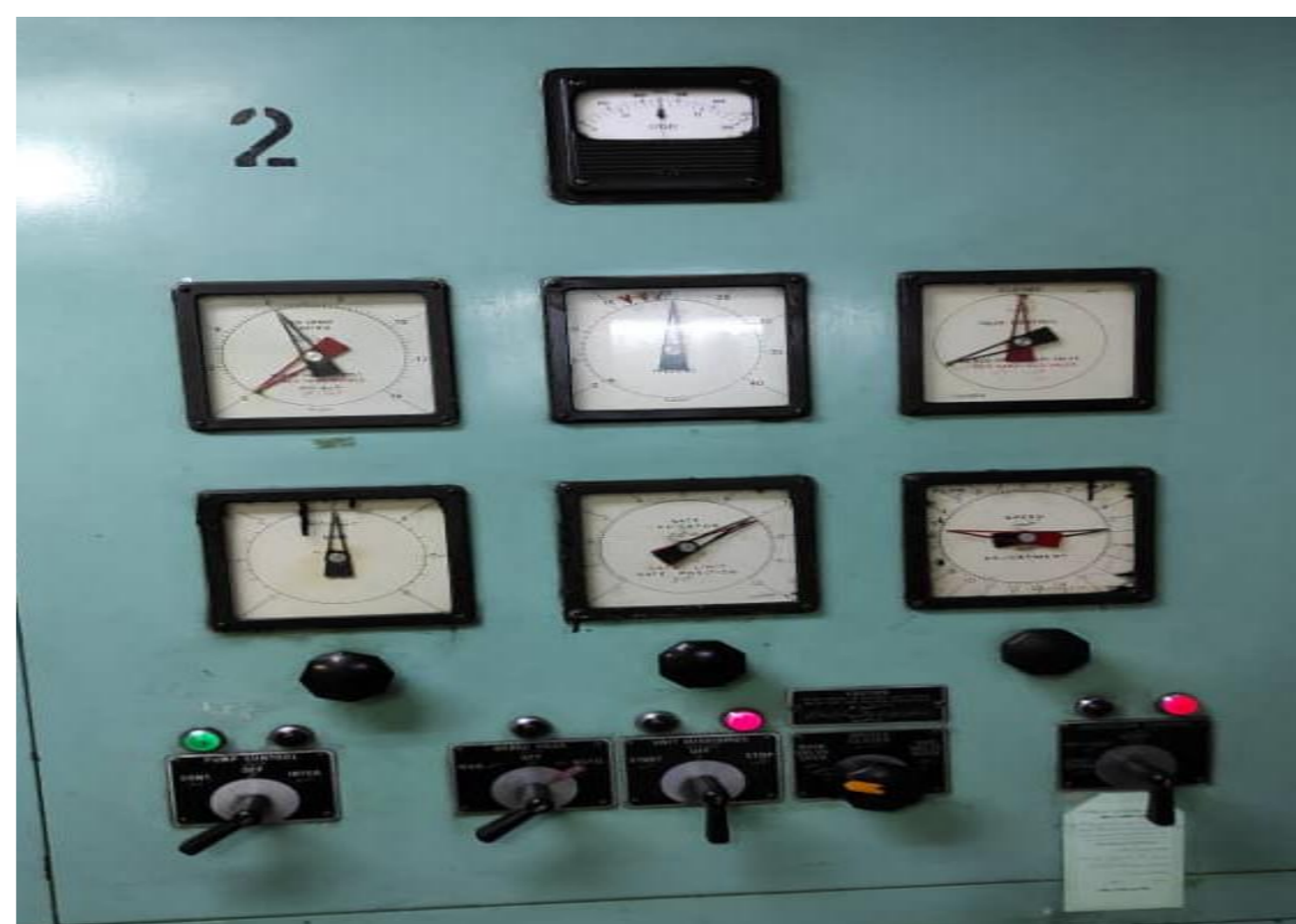
شکل ۱ گیج و پیچ تنظیم های کابینت گاورنر
