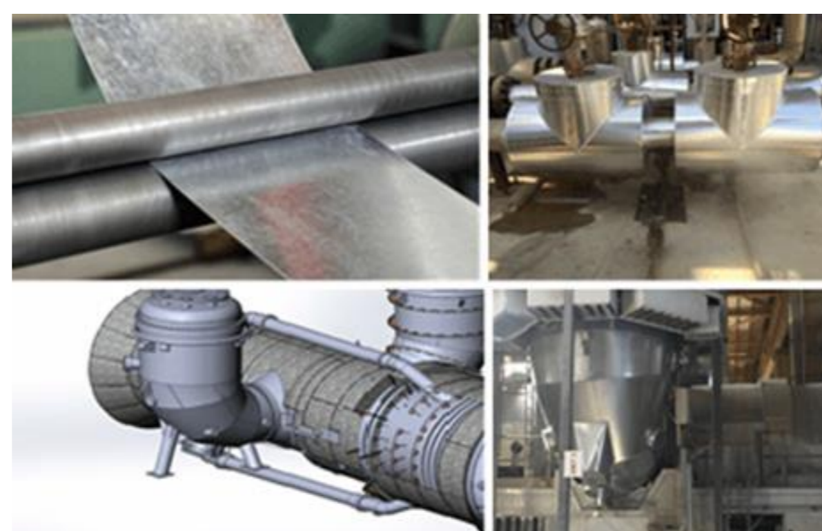
شکل ۲ عایق‌های فلزی-حرارتی (Cladding)
