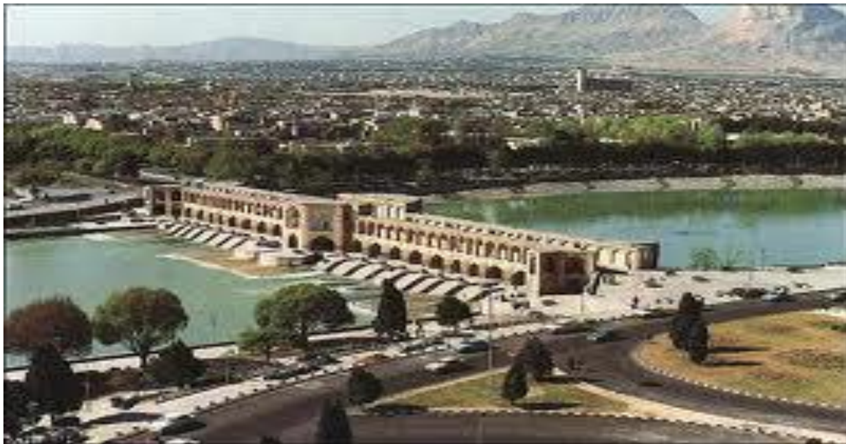
ابرسامانه پل خواجهی اصفهان
