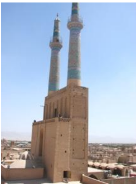
تصویر ۱۵ - عظمت و جلال مسجد در کل بافت شهر مسجد جامع یزد . ( آرشو دانشکده معماری دانشگاه علم و صنعت ایران )
