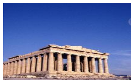
تصویر ۷-۵۹- ریتم های ثابتی تکرار می شود، حال و هوای مجسمه ای و بی تفاوت نسبت به بیرون دارد، پارتون، آتن.
